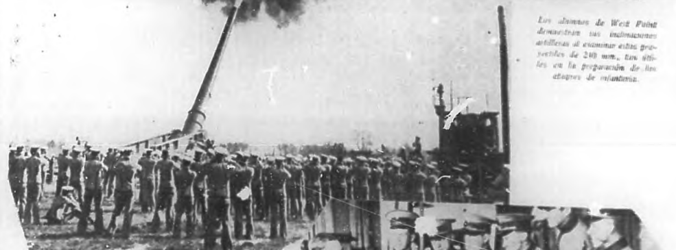
Los alumnos de West Point presenciando las prácticas de cañón en el polígono de Aberdeen. Una pieza de 16" (las mayores con que cuenta la artillería americana) empujando a quince kilómetros de distancia un proyectil de 1.000 kg. Estos cañones están destinados a mantener los barcos enemigos lejos de la costa yankee.
